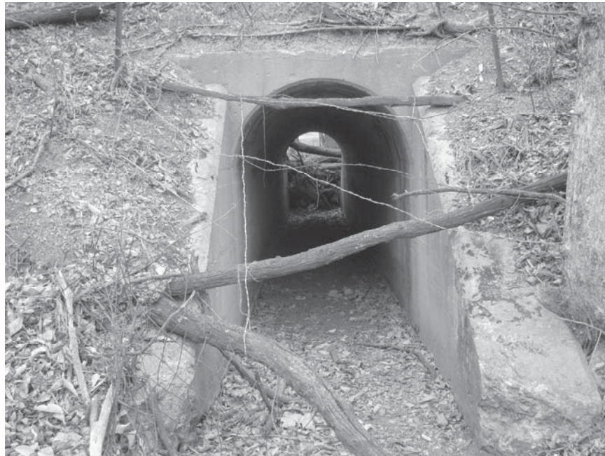
C 2074.jpg. Culvert #2074.
